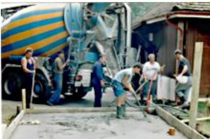
Alexander's Bautrupps sorgt für ein solides Fundament
