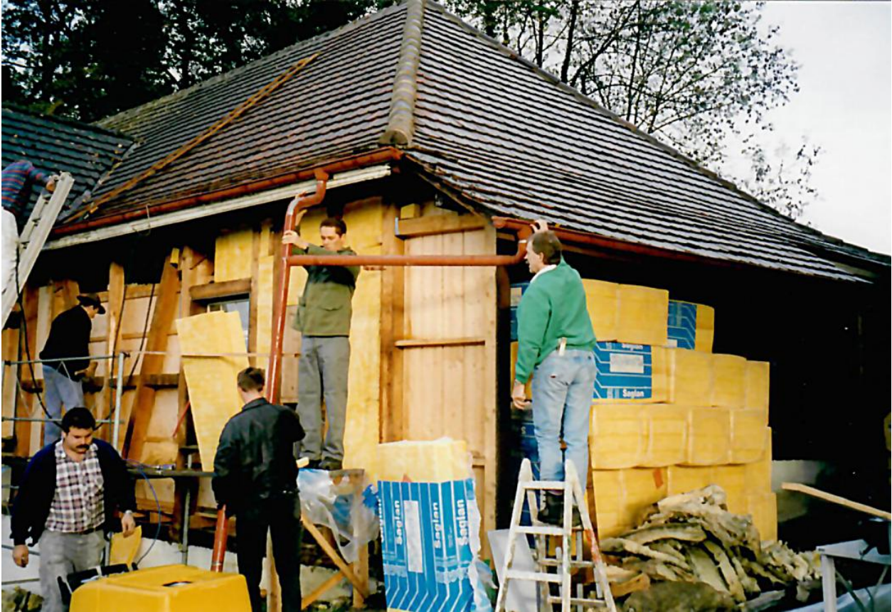
Renovation Fassade, Einbau Büro 1998
