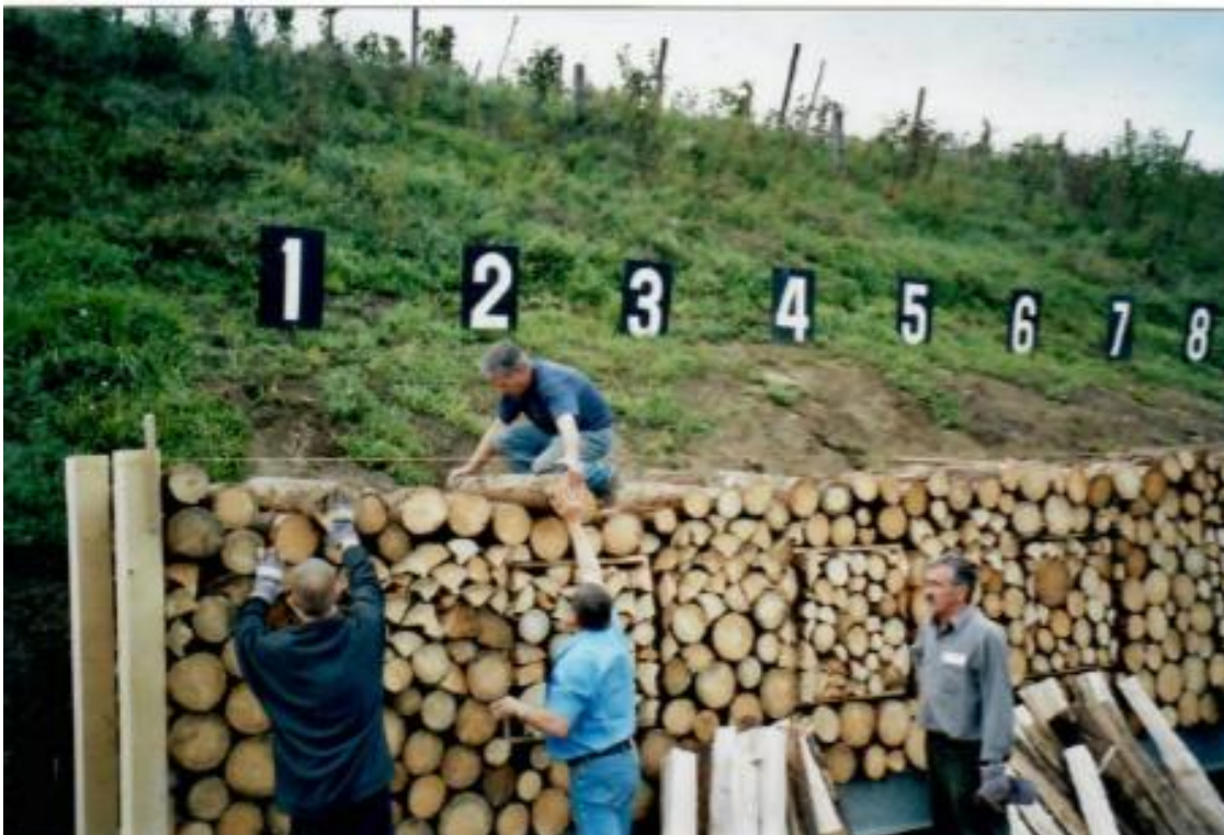
Die neuen Holzkugelfänge wurden 2005 aufgebaut und seither jährlich erneuert
